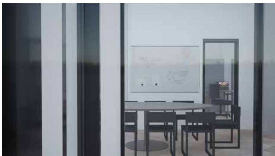
Obr. 5c Zjištěný nežádoucí průhled z veřejně přístupného oddechového prostoru, přes chodbu a zasedací místnost na pracovní stůl v kanceláři výrobního ředitele
